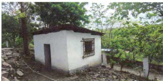
Foto1: Sustitución de cubierta de lámina en cocina
