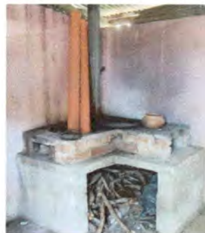
Foto 4: Reparación estufa rural
