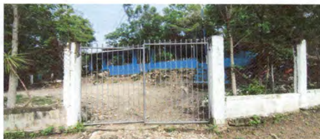
Foto 6: Mantenimiento de portón
