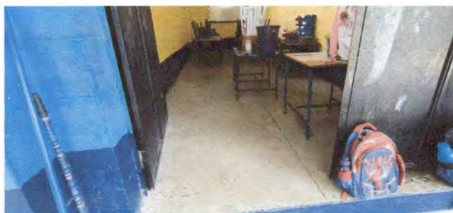
Foto 5: Sustitución de piso cerámico
