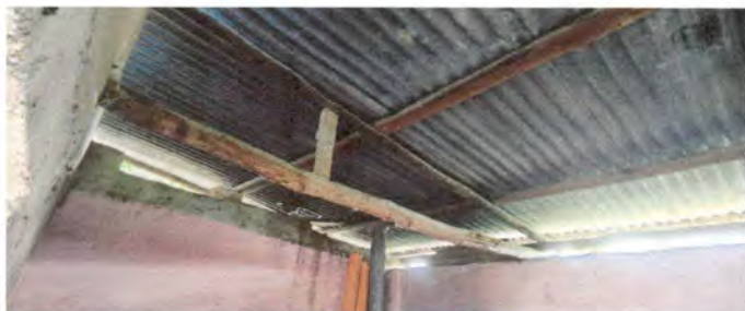
Techo de la cocina
