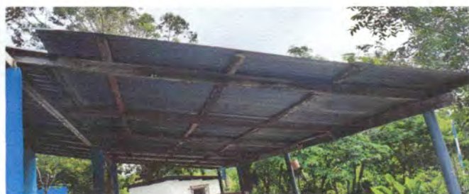
Foto 4: Sustitución de techo, costaneras y láminas.
