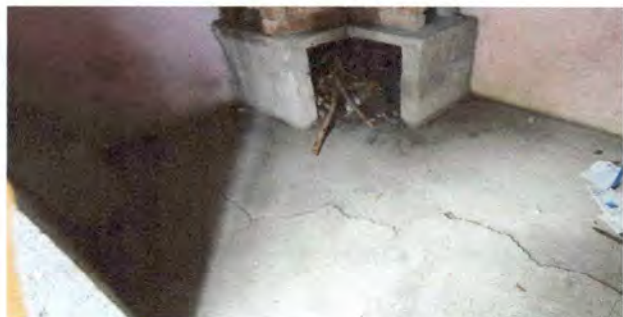
Foto 5: Sustitución de piso de cocina por cemento líquido.
