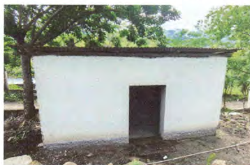
Foto 2: Colocación de puerta en cocina
