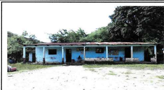
Foto 1: Estado actual del techo
