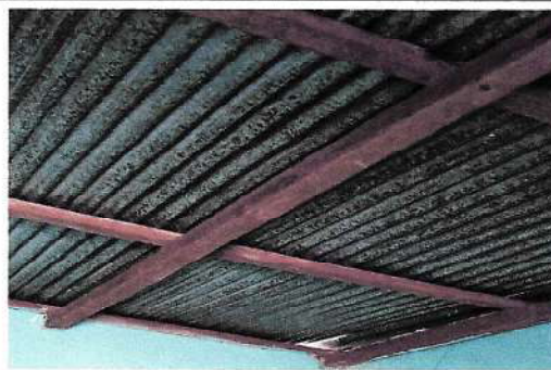
Foto 2: Sustitución de techo de madera por metal
