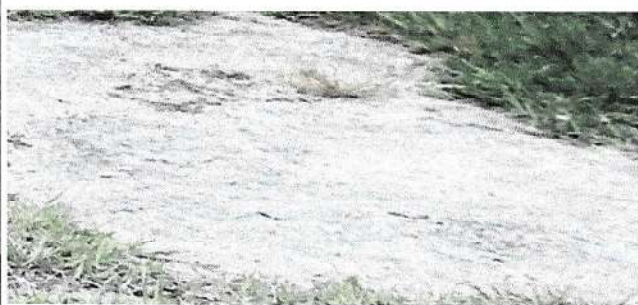
Foto 3: Losa de patio
