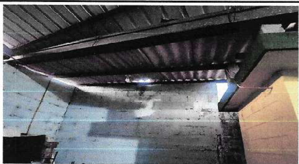
Foto 1: Cubierta de lámina y estructura de techo
