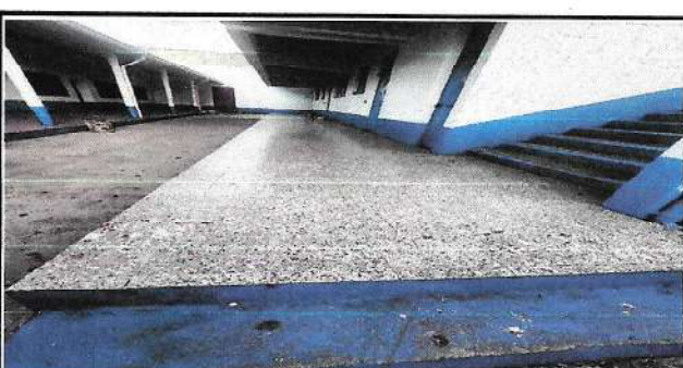
Foto 6: Mantenimiento de piso
