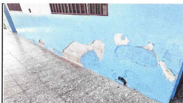
Foto 6: Repello en mal estado de las paredes de las aulas.
