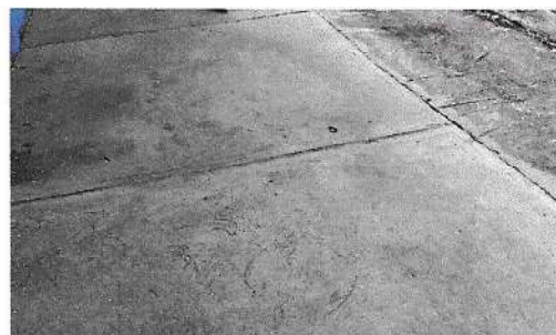
Foto 6: PISO TORTA DE CEMENTO
