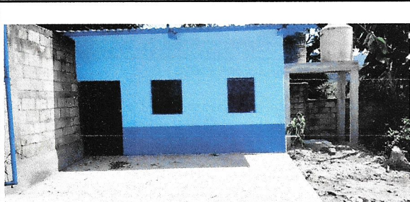
Foto 8: LOSA DE PATIO
