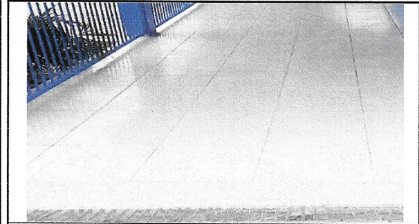
Foto1: PISO EN CORREDOR
