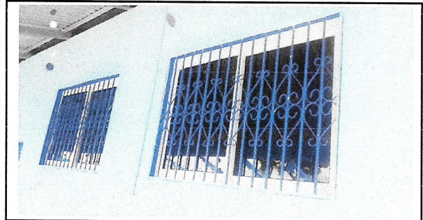
Foto 5: VENTANAS EN AULAS
