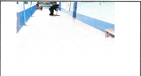
Foto 2: PISO EN CORREDOR
