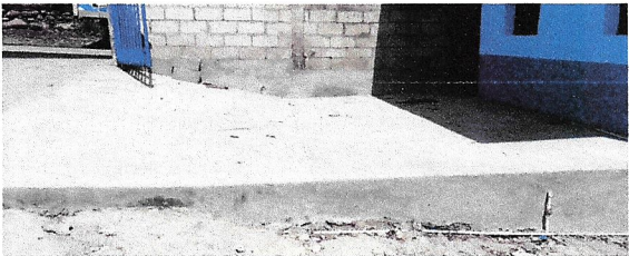
Foto 9: LOSA DE PATIO
