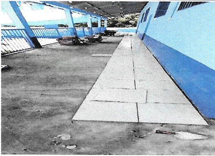
Foto 2: PISO EN CORREDOR
