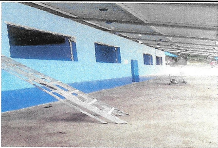
Foto 5: VENTANAS EN AULAS
