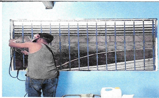
Foto 6: VENTANAS EN AULAS
