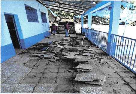
Foto1: PISO EN CORREDOR
