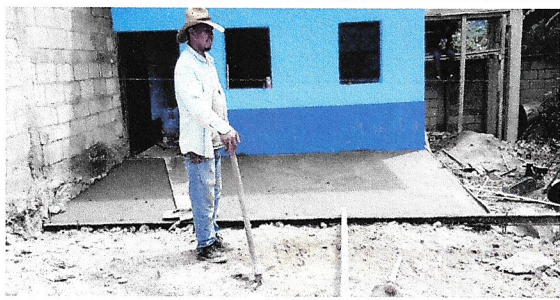
Foto 9: LOSA DE PATIO
