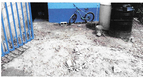
Foto 8: LOSA DE PATIO
