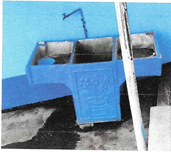
Foto 10: PILA DE COCINA
