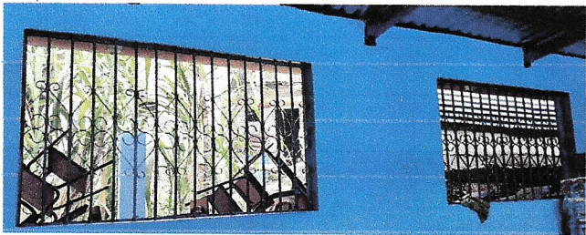
Foto 5: VENTANAS EN AULAS
