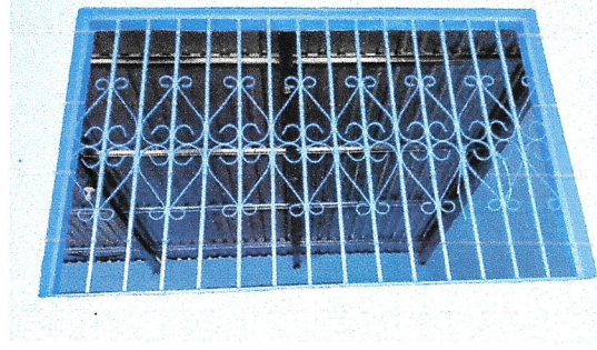
Foto 6: VENTANAS EN AULAS
