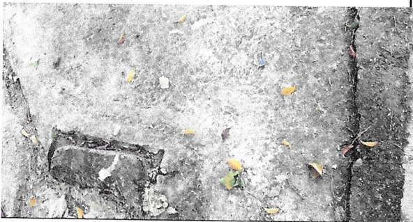
Foto 7: LOSA DE PATIO
