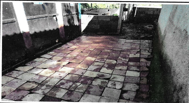
Foto 3: CAMBIO DE PISO POR LOSA DE CEMENTO AREA DE BAÑOS
