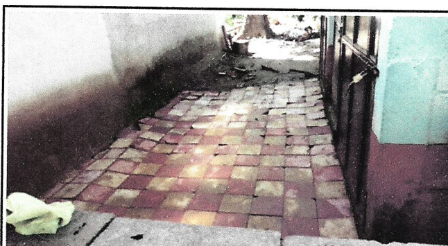
Foto 4: CAMBIO DE PISO POR LOSA DE CEMENTO AREA DE BAÑOS
