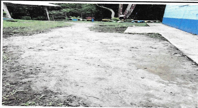
Foto 1: CAMBIO DE LOSA ENTRADA PRINCIPAL
