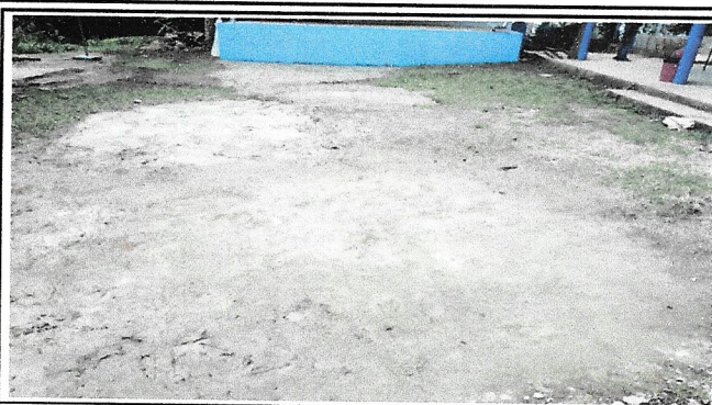
Foto 2: CAMBIO DE LOSA DEL PATIO
