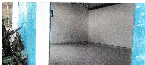
Foto 3: PISO CERAMICO EN AULA
