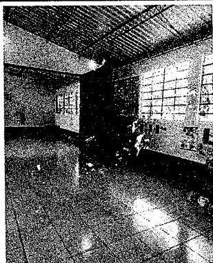
Foto 15: CAMBIO DE PISO DE CEMENTO POR PISO CERÁMICO.
