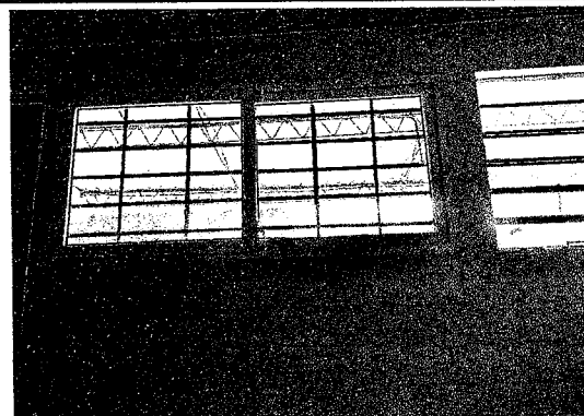
Foto 18: CAMBIO A VENTANAS PVC.
