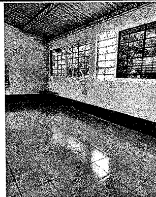
Foto 14: CAMBIO DE PISO DE CEMENTO POR PISO CERÁMICO.
