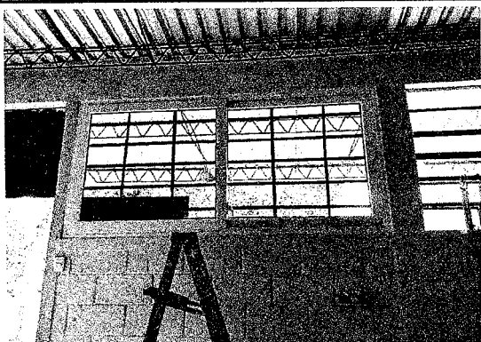
Foto 17: CAMBIO A VENTANAS PVC.
