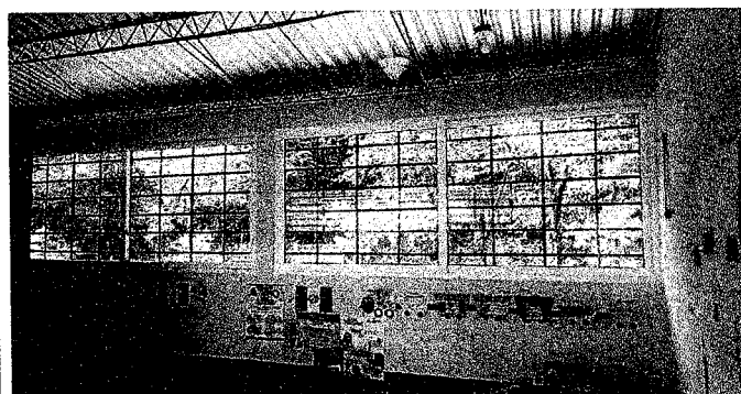
Foto 16: CAMBIO A VENTANAS PVC.
