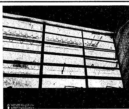
Foto 6: VENTANAS EN AULAS
