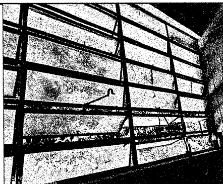
Foto 5: VENTANAS EN AULAS
