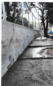
Foto 3: Finalización de muro perimetral con elevación de dos hileras de block y malla
