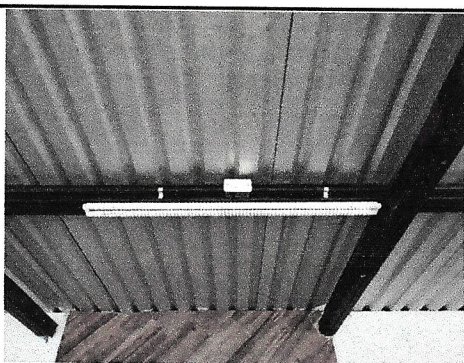
Foto 5: aulas 1,2 y 3 Finalización de reposición de lámparas tipo listón
