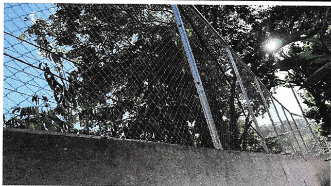
Foto1: Finalización de muro perimetral
