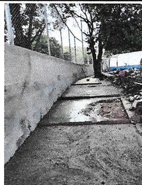
Foto 4: Proceso de reposición de repello para evitar humedad en muro perimetral
