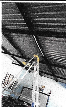
Foto 5: aulas 1,2 y 3 proceso de reposición de lamparas tipo liston
