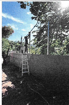
Foto 1: Proceso de muro perimetral
