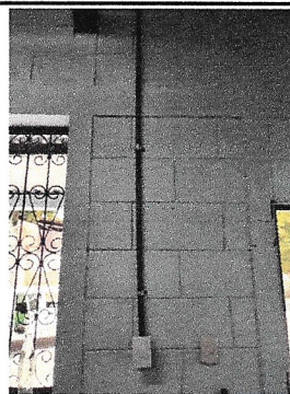
Foto 6: aula no. 3 Proceso de reposición de ducto electrico
