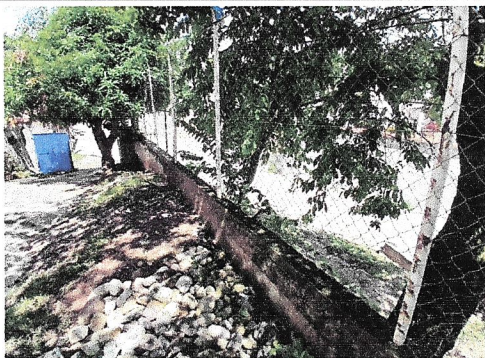
Foto 1: Muro perimetral: baja altura, malla rota necesita elevarse altura por seguridad de los niños
