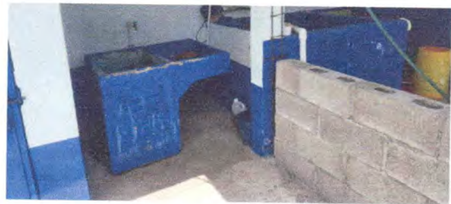
Foto 6: PILA DE COCINA
