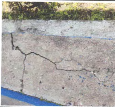
Foto 3: BANQUETA DE CONCRETO
