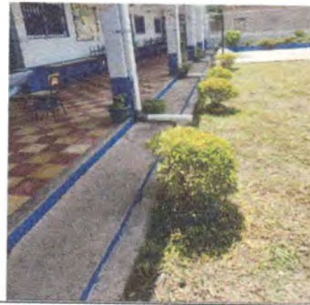
Foto 2: BANQUETA DE CONCRETO
