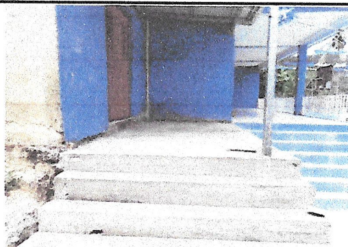
Foto 5: REPARACION DE LOZA DE PATIO
