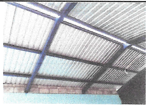
Foto 2: SUSTITUCIÓN DE LAMINA EN MAL ESTADO CALIBRE 26 POR LAMINA DE ALUCIN CALIBRE 24.
