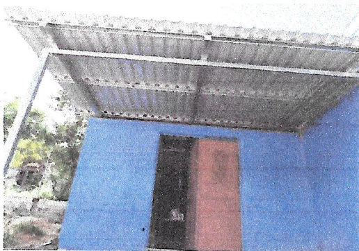
Foto 3: SUSTITUCIÓN DE ESTRUCTURA DE MADERA POR ESTRUCTURA DE METAL
