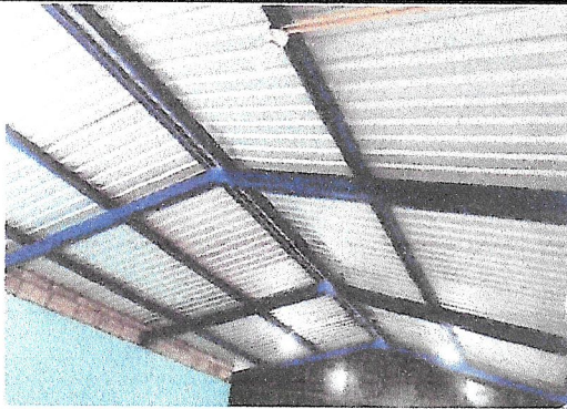
Foto 1: MANTENIMIENTO A ESTRUCTURA DE METAL DE TODO EL EDIFICIO
