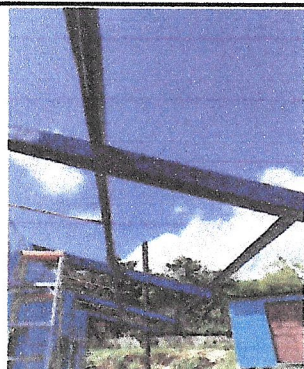
Foto 1: MANTENIMIENTO A ESTRUCTURA DE METAL DE TODO EL EDIFICIO
