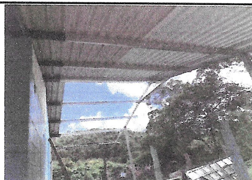
Foto 4: SUSTITUCION DE ESTRUCTURA DE MADERA POR ESTRUCTURA DE METAL GALERA DE PILA
