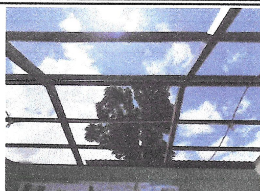
Foto 2: SUSTITUCIÓN DE LAMINA EN MAL ESTADO CALIBRE 28 POR LAMINA DE ALUCIN CALIBRE 24.
