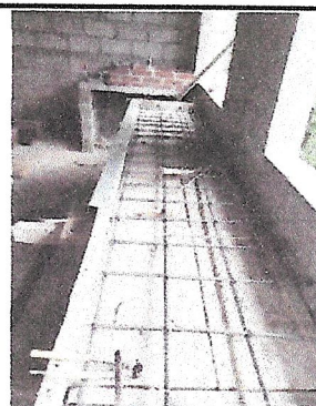
Foto 6: REPARACION DE PISO DE CONCRETO AREA DE COCINA
