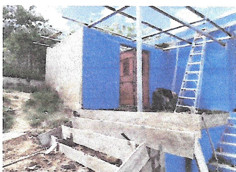
Foto 5: REPARACION DE LOZA DE PATIO AREA DE BODEGA
