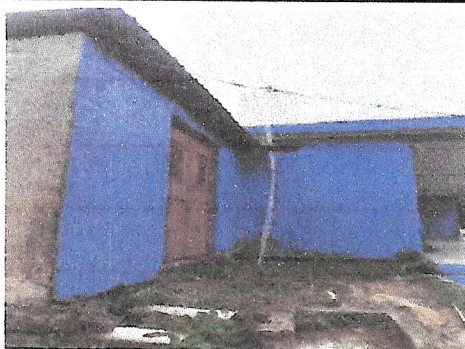
Foto 5: REPARACION DE LOZA DE PATIO
