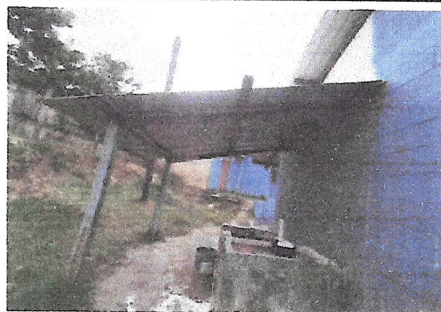
Foto 4: SUSTITUCION DE ESTRUCTURA DE MADERA POR ESTRUCTURA DE METAL
