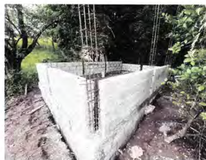
Foto 2: MUROS DE AULA
