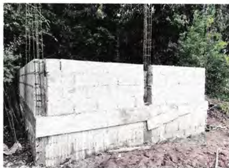
Foto 5: MUROS DE AULA PARTE TRASERA
