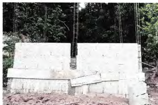
Foto 4: MUROS DE AULA PARTE LATERAL
