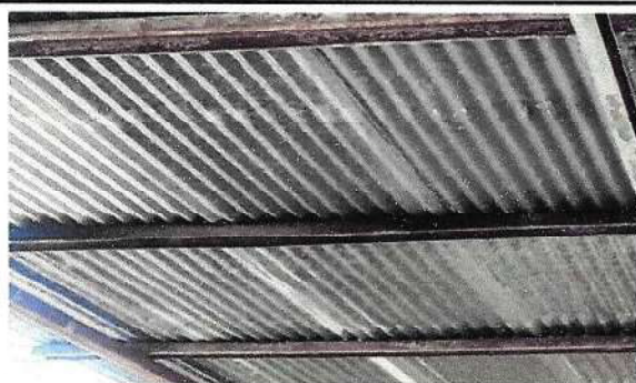
Foto 3: CUBIERTA DE LÁMINA
