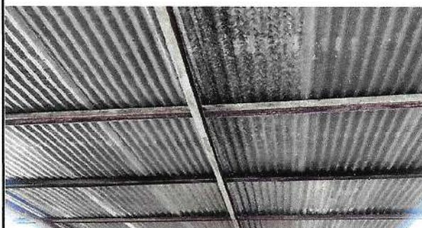
Foto 2: ESTRUCTURA DE TECHO
