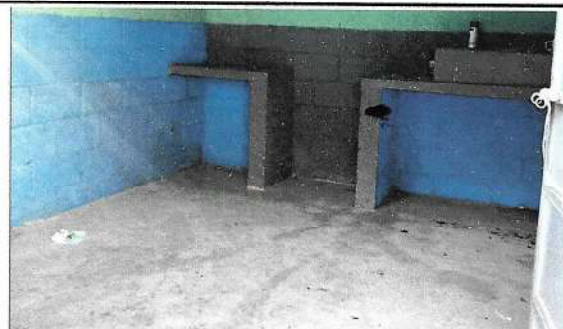
Foto 6: REPARACIÓN DE AZULEJO DE COCINA
