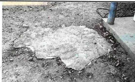
Foto 4: LOSA DE PATIO
