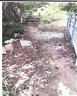
Foto 5: Sustitución de piso de torta de concreto
