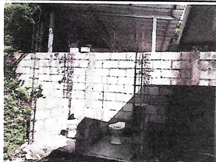
Foto 2: Continuación de muro de block en baños
