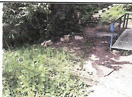
Foto 6: Sustitución de piso de torta de concreto
