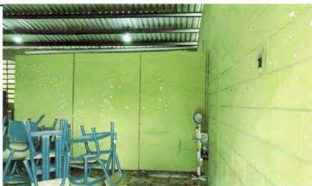
PINTURA DE MUROS INTERIORES
