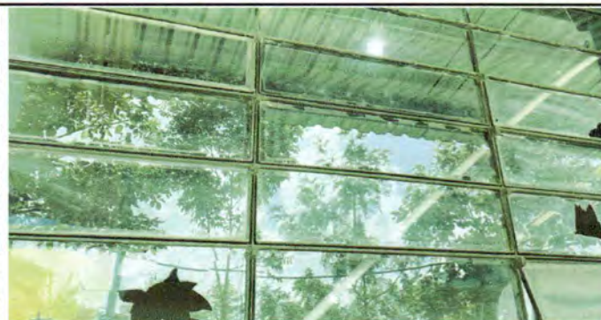
SUSTITUCION DE VENTANAS Y MANTENIMIENTO A ESTRUCTURA
