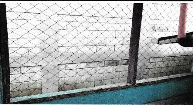
Foto 3: sustitución de malla por reja
