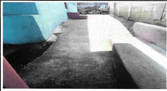
Foto 2: sustitución de piso de concreto por piso cerámico en el área de afuera de los baños y bajada del aula de párvulos.
