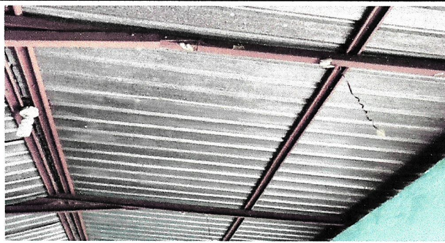
Foto 1: Sustitución de lámina y estructura metálica.
