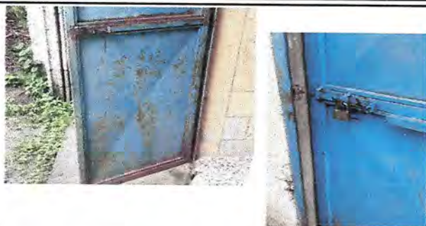
Foto1: Mantenimiento de puertas
