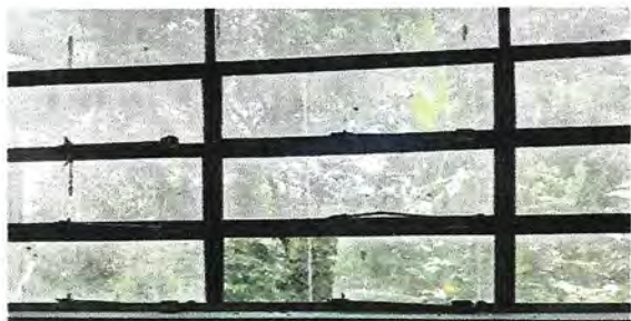
Foto 5: sustitucion de ventanas
