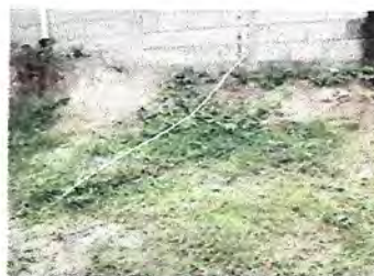
Foto 6: sustitucion de tuberia de agua
