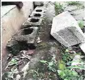
Foto 3: reparacion de cuneta que capta bajadas de agua pluvial
