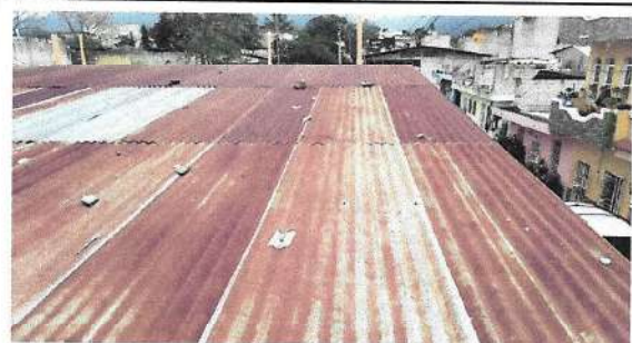
Foto 2: Cambio de cubierta de lámina y estructura de techon de salon principal
