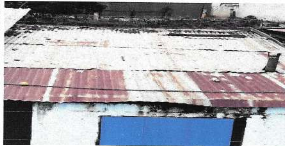
Foto 1: Repello y cubierta de lámina y estructura de techo.
