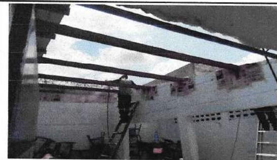
Foto 3: Sustitución estructura de metal por la madera de un Salón de clases
