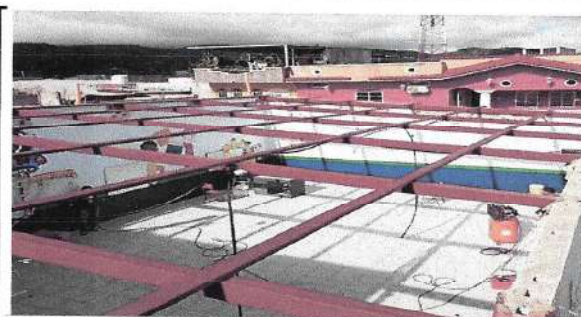
Foto 4: Mantenimiento de estructura de metal del salon principal.
