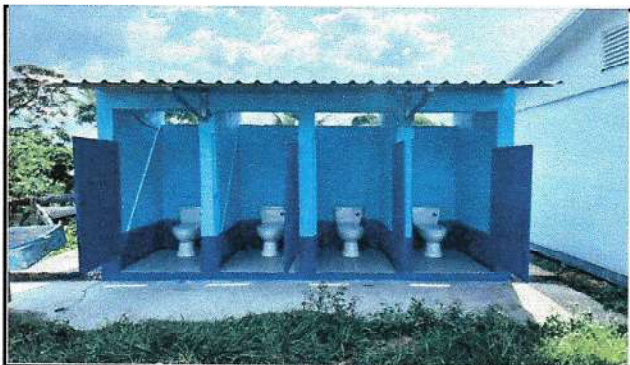
Foto 1: vista remozamiento servicios sanitarios.
