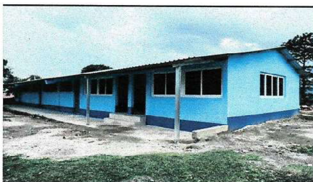
Foto 2: vista remozamiento del aula.
