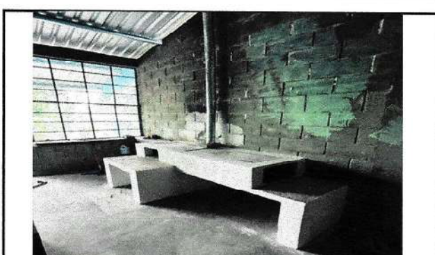
Foto 6: Vista remozamiento de chimenea.
