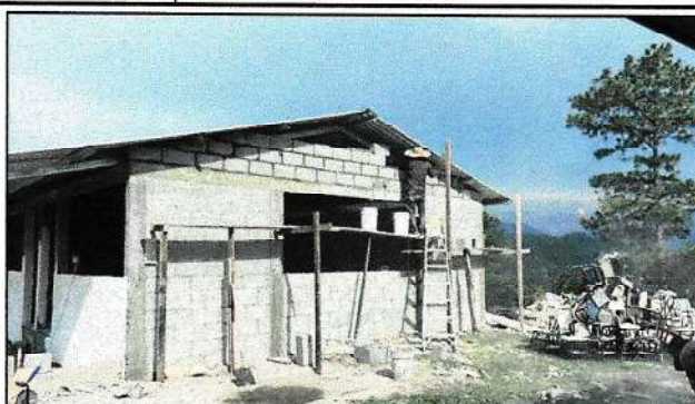
Foto 2: remozamiento de aula
