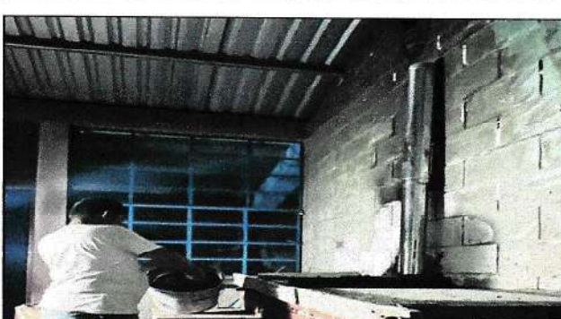
Foto 6: Instalación de Chimenea
