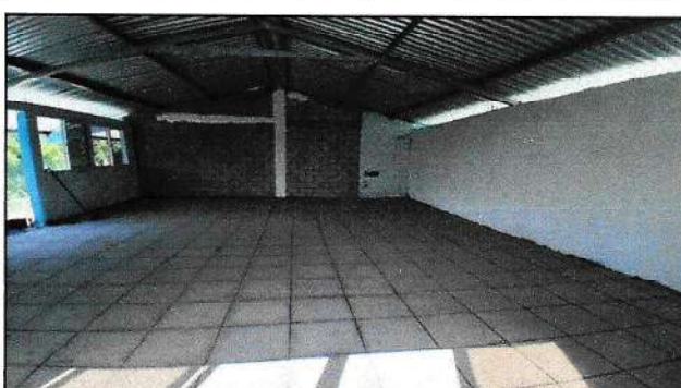
Foto 4: sustitución de piso de concreto a piso cerámico
