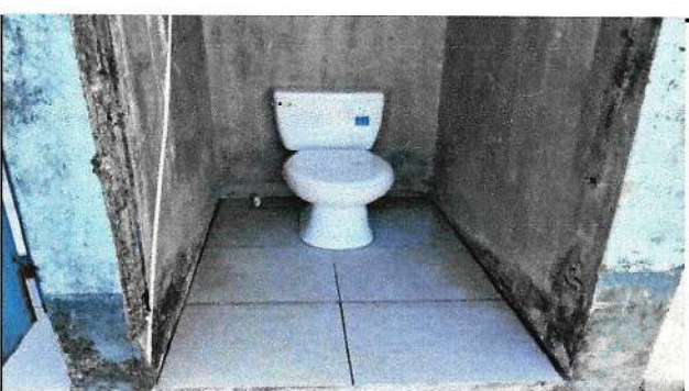
Foto 5: Sustitución de inodoro y piso en baños
