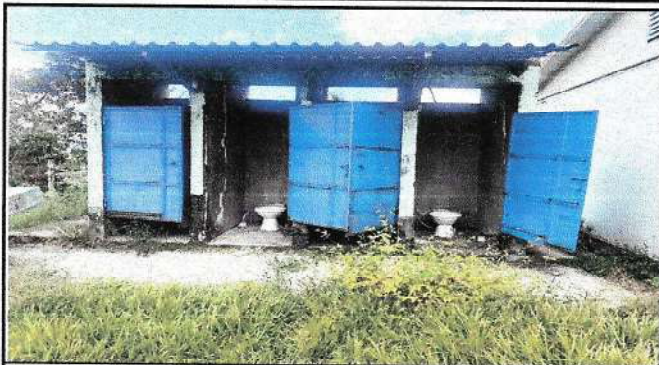
Foto1: Situación actual, módulo de baños
