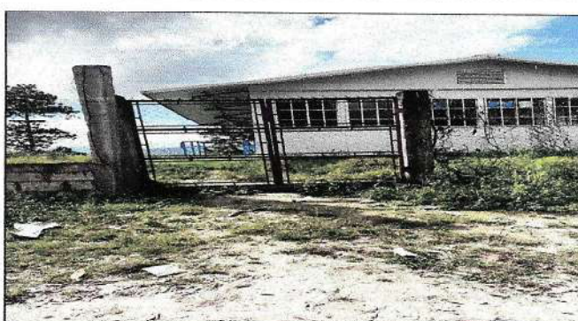
Foto 4: Porton e ingreso a la escuela
