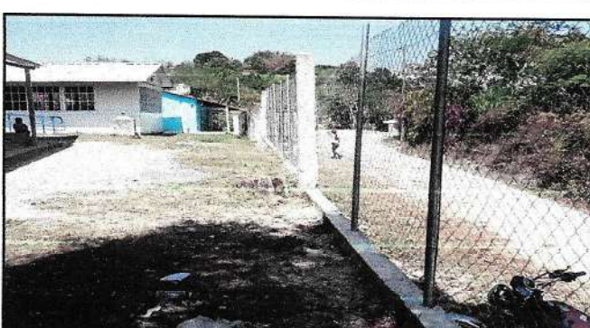
Foto 6: Vista muro perimetral
