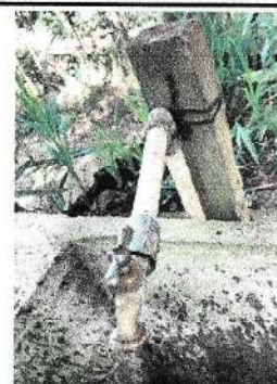
Foto 2: Sustitución de llave de chorro.
