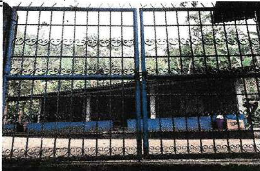
Foto 1: Mantenimiento a portones.
