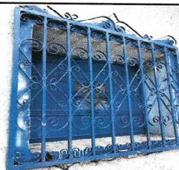
Foto 6: Mantenimiento a balcones de metal.
