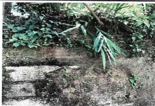
Foto 4: Reparación de muros de contención.
