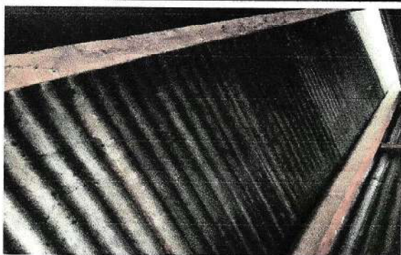
Foto 3: Sustrución de estructura de madera por metal.
