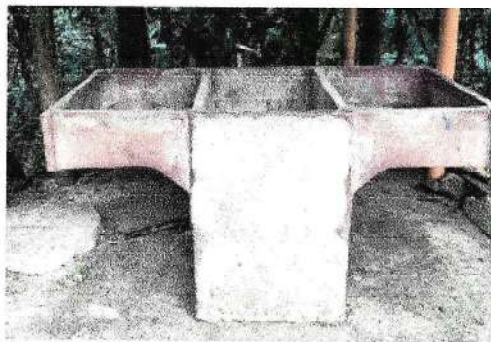
Foto 3: Sustitución de pila de cemento.
