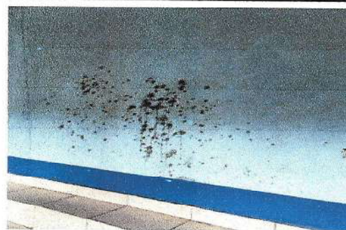
Foto 6: Pintura en interiores y exteriores.
