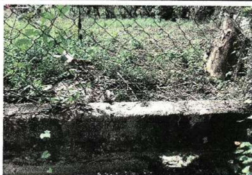
Foto 3: Reparación de muro perimetral de block con tubo hg y malla galvanizada.
