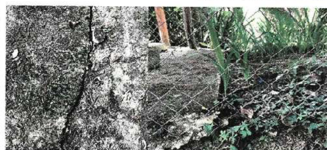
Foto 4: Reparación de plancha de concreto de patio.
