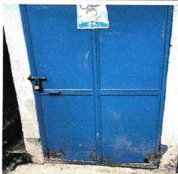
Foto 1: Pintura a puerta de servicios sanitarios.
