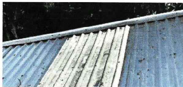
Foto 2: Sustrución de Capote
