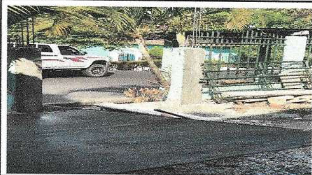
Foto 3: arreglo de portón
