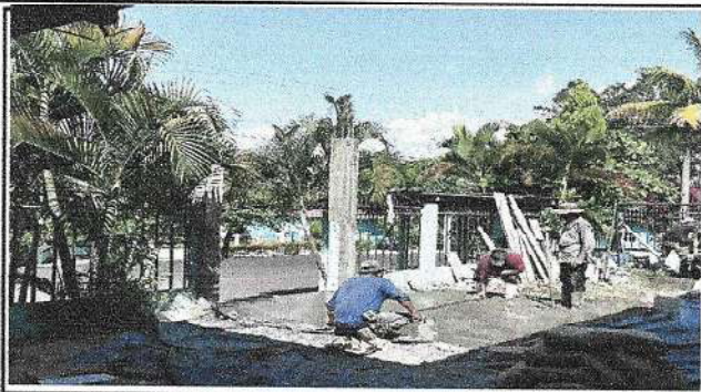
Foto 1: Sustitución de piso
