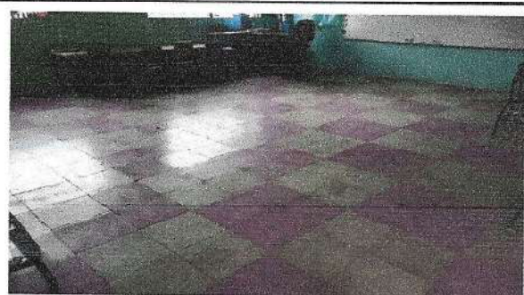
Foto 4: Sustrución de piso
