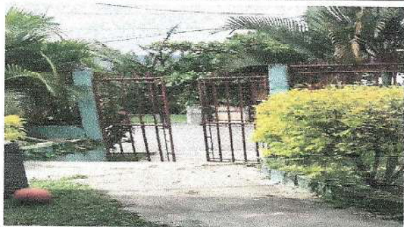
Foto 3: Sustrución de portón
