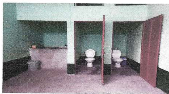
Foto 2: Sustrución de inodoros y arreglo de pila
