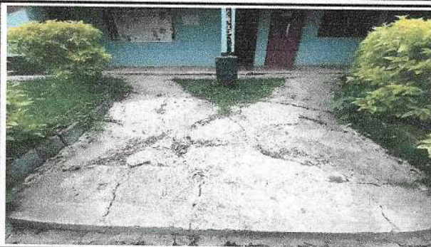
Foto1: Sustrución de piso
