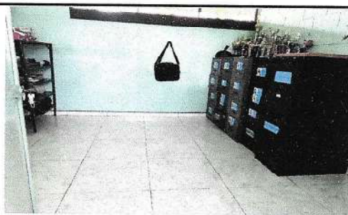
Foto 3: Finalización de sustitución de Piso Cerámico
