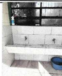
Foto 2: Finalización de sustitución de Piso Cerámico en baños
