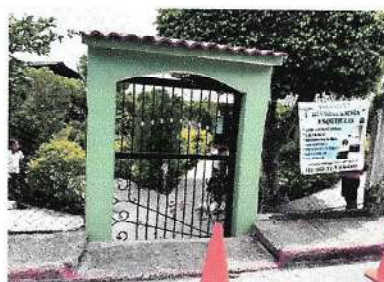
Foto 6: Finalización de sustitución de Puerta de Metal.
