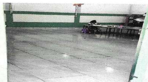
Foto 4: finalización de sustitución de Piso Cerámico en las aulas
