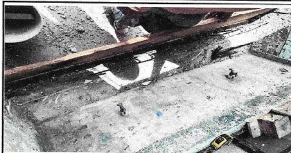
Foto 2: Proceso de sustitución de Piso Cerámico en baños
