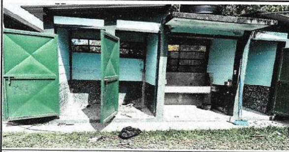
Foto 1: Proceso de la sustitución de Piso y Baños
