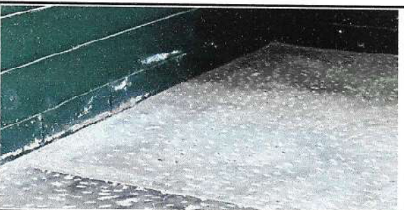
Foto 5: Proceso de sustitución de Piso Cerámico
