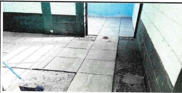
Foto 3: Proceso de sustitución de Piso Cerámico
