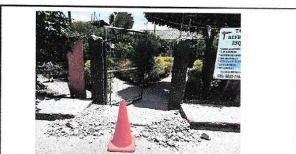
Foto 6: Proceso de sustitución de Puerta de Metal
