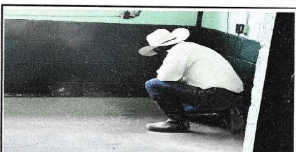
Foto 4: Proceso de sustitución de Piso Cerámico
