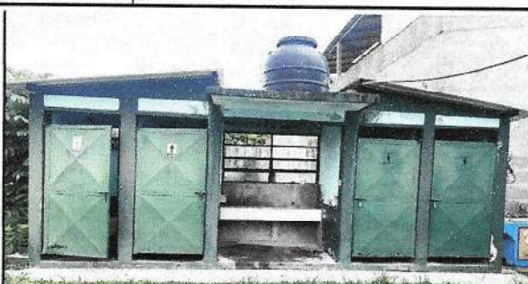
Foto 2: Sustitución de Piso Cerámico
