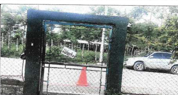
Foto 6: Sustitución de Puerta de Metal
