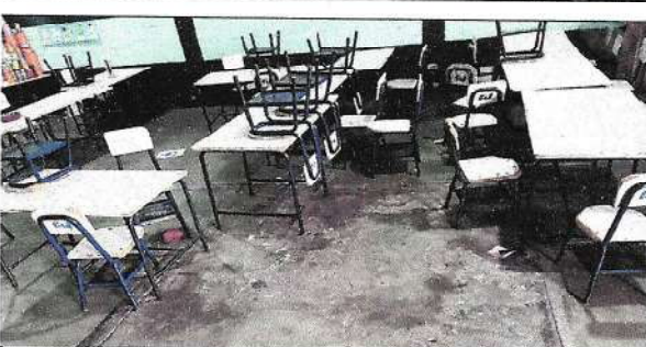
Foto 4: Sustitución de Piso Cerámico
