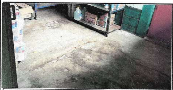
Foto 5: Sustitución de Piso Cerámico
