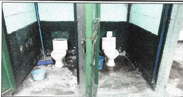
Foto1: Sustitución de Piso y Baños
