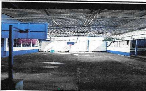
Foto 5: Reparación de canchas de concreto de patio
