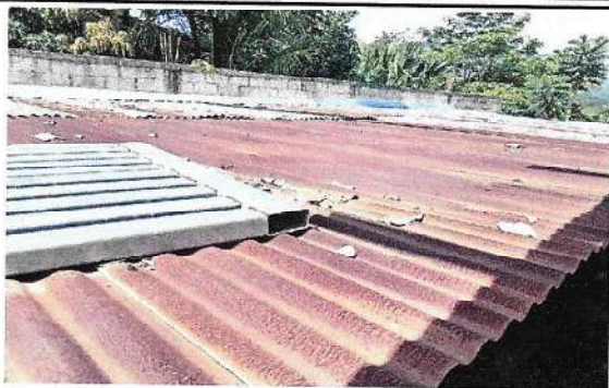
Foto 1: Sustrucción de lámina troquelada aluzin calibre 26
