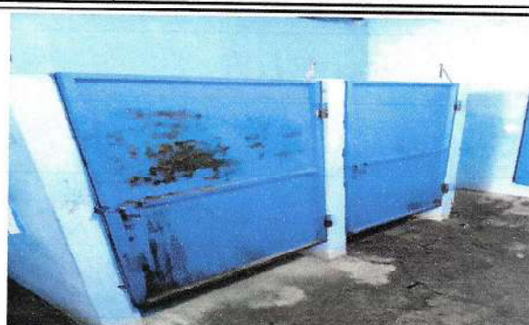
Foto 2: Puerta de Metal: Mantenimiento a estructura lijado, cepillado y aplicación de pintura
