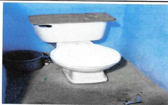
Foto 6: Sustrucción de Sanitario
