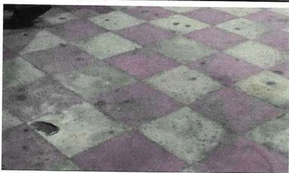
Foto 3: Piso: Sustrucción de piso cerámico
