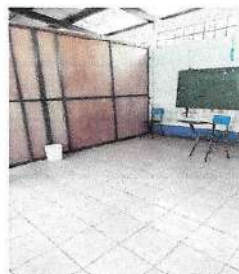
Foto 8: Sustitución de separador de salones
