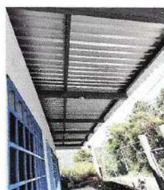
Foto:10 Mantenimiento a estructura de soporte de metal
