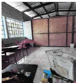
Foto7: Sustitución de piso de torta de cemento
