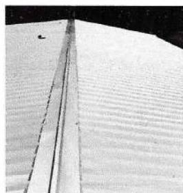
Foto : Sustitución de lámina, por lámina troquelada aluzinc calibre 26
