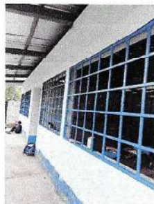
Foto 5: Pintura de exteriores e interiores
