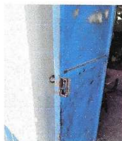
Foto:4 Sustitución de chapa, aplicación de pintura
