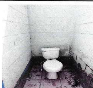
Foto 3: Instalación de inodoro
