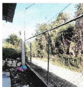
Foto:10 Mantenimiento a estructura de soporte de metal
