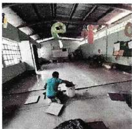
Foto7: Sustitución de piso de torta de cemento
