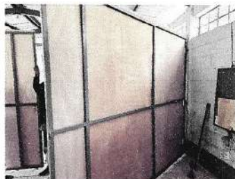
Foto 8: Sustitución de separador de salones
