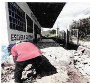
Foto1: Reparación de banqueta de concreto
