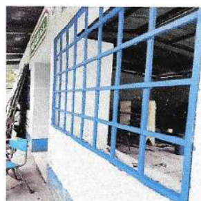
Foto 2: Mantenimiento a estructura de metal
