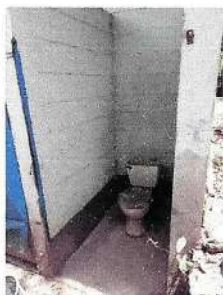
Foto 3: Instalación de inodoro
