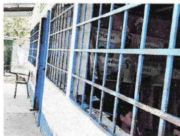
Foto 2: Mantenimiento a estructura de metal
