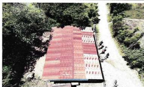
Foto 9: Sustitución de lámina, por lámina troquelada aluzinc calibre 26
