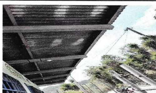
Foto:10 Mantenimiento a estructura de soporte de metal
