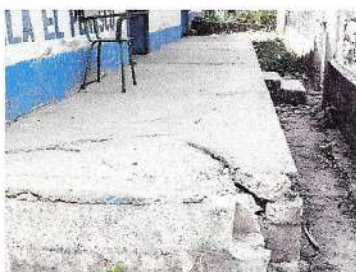
Foto1: Reparación de banqueta de concreto
