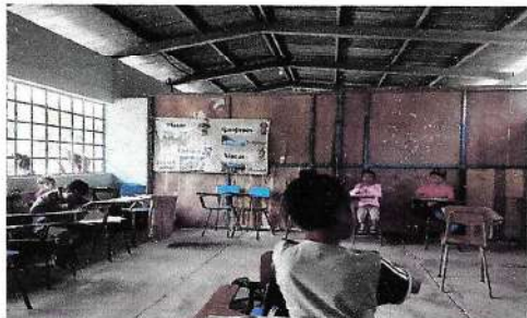
Foto7: Sustitución de piso de torta de cemento
