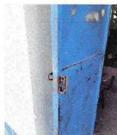
Foto:4 Sustitución de chapa, aplicación de pintura
