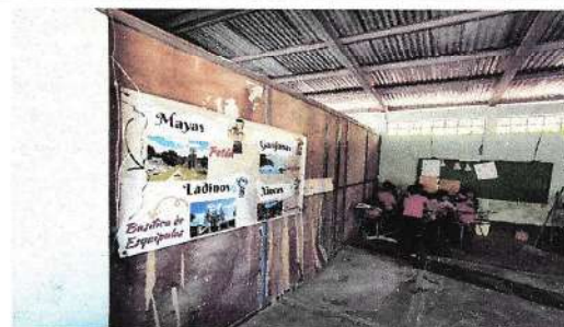
Foto 8: Sustitución de separador de salones
