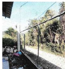
Foto 6: Reparación de tubo hg y malla galvanizada
