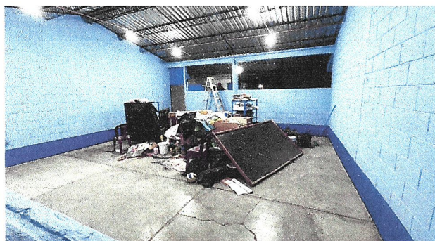
Foto 3: Sustrucción de Piso Cerámico
