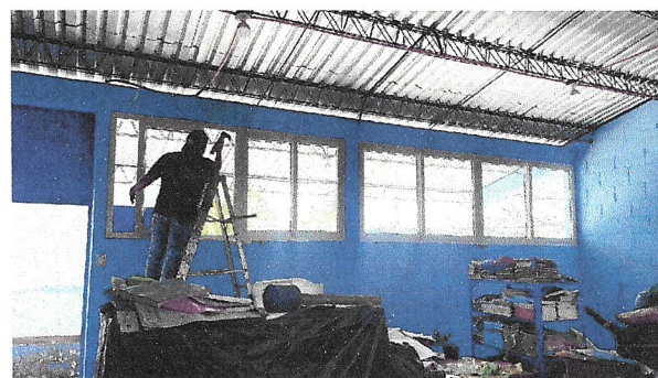
Foto 6: Sustrucción de Ventanas
