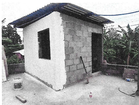
Foto 5: Reparación de Cocina
