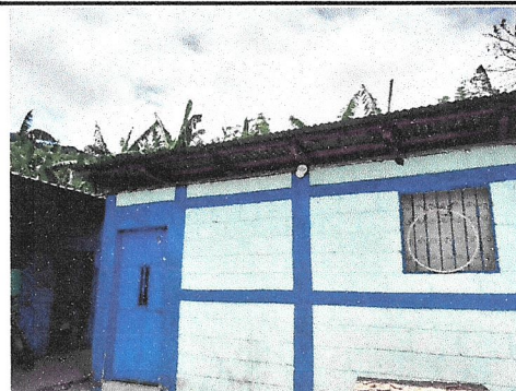
Foto 4: Pintura en Muros Exteriores e Interiores
