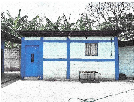
Foto1: Sustitución de Estructura de Metal, por Metal
