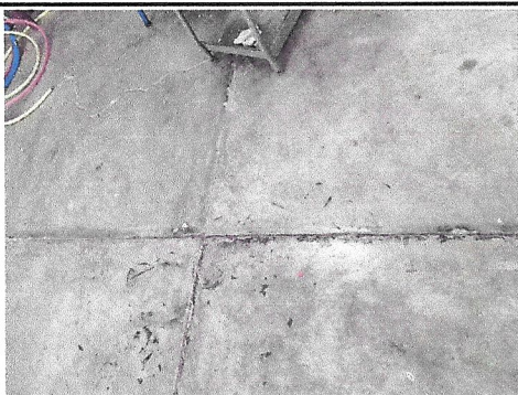
Foto 3: Sustitución de Piso Cerámico
