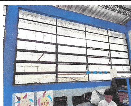
Foto 6: Sustitución de Ventanas
