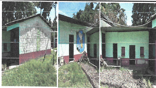
Foto1: Mantenimiento de pintura sustitución de chapa
