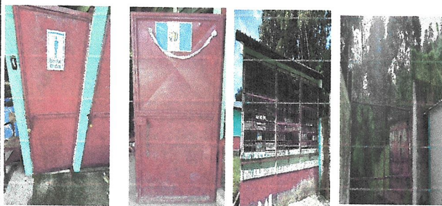
Foto 3: Mantenimiento de balcones y puertas
