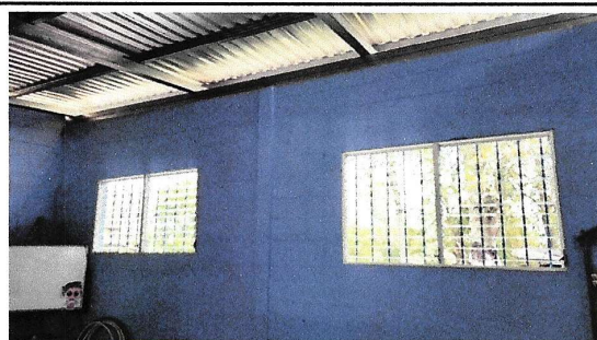
Foto 4: Sustitución de ventana de vidrio por aluminio y vidrio.
