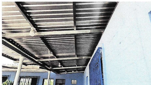
Foto 2: Sustitución de lámina, por lámina troquelada de aluzinc calibre 26
