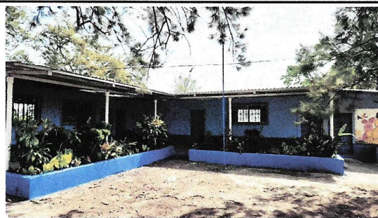
Foto 6: Pintura en muros exteriores e interiores.
