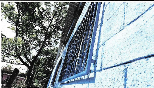
Foto 5: Sustitución de balcones de metal
