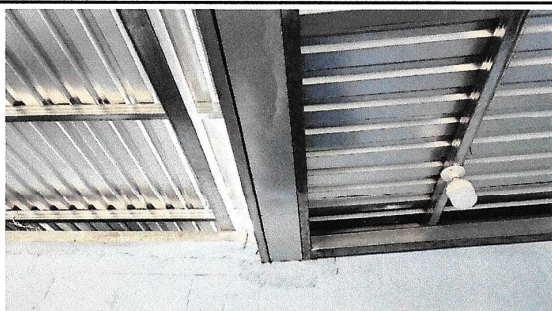
Foto 3: Sustitución de lámina, por lámina troquelada de aluzinc calibre 26
