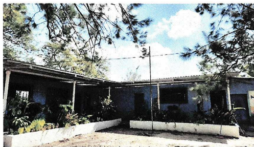
Foto 6: Pintura en muros exteriores e interiores.
