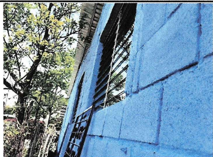
Foto 5: Sustitución de balcones de metal
