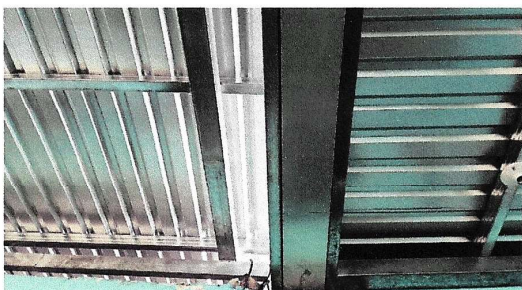
Foto 3: Sustitución de lámina, por lámina troquelada de aluzinc calibre 26
