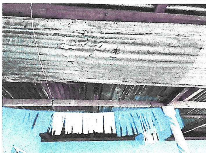
Foto 3: Sustitución de lámina, por lámina troquelada de aluzinc calibre 26
