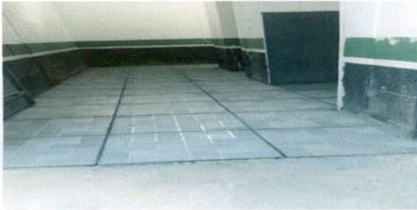
Foto 3: Sustitución de piso de cemento liquido
