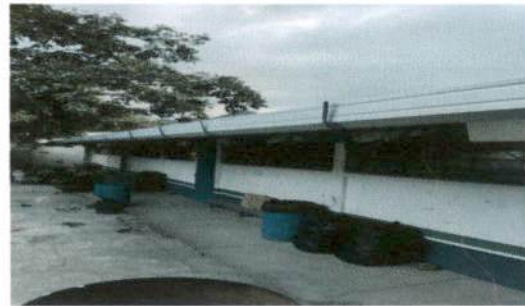
Foto 4: Instalación de canal de metal
