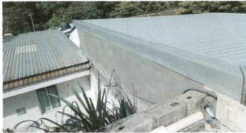
Foto 7: Repello en muro
