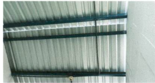
Foto 2: Mantenimiento a estructura de soporte de metal
