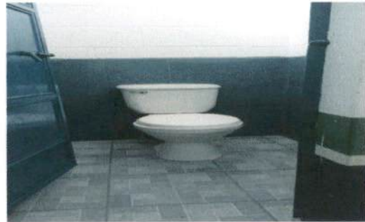
Foto 8: Sustitución de inodoro
