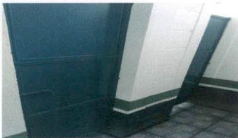
Foto 5: Mantenimiento a estructura (lijado, cambio de tubo, cepillado, sujeciones, aplicación de pintura) a puertas servicios sanitarios
