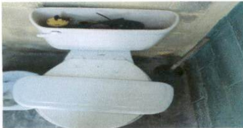
Foto 9: Sustitución de accesorios inodoro (contra llave, tubo de abasto y tanque)
