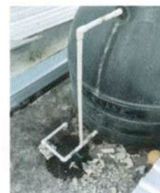
Foto 6: Sustitución de accesorios deposito de agua
