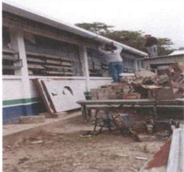
Foto 12: Instalación de canales de metal
