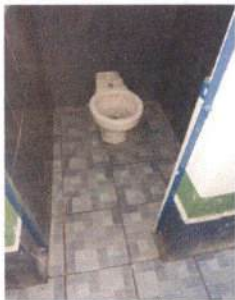
Foto 8: Sustitución de inodoro
