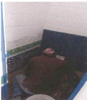
Foto 4: Sustitución de inodoro
