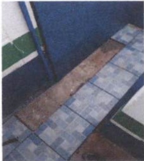
Foto 8: Sustitución de piso
