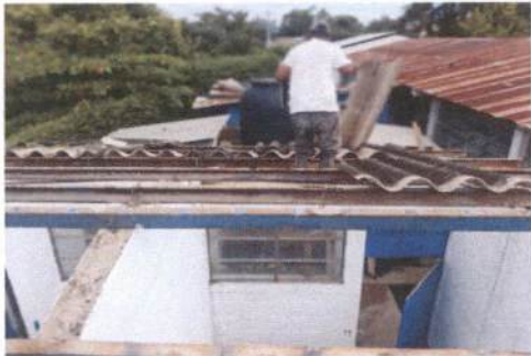
Foto 1: Sustitución de lámina
