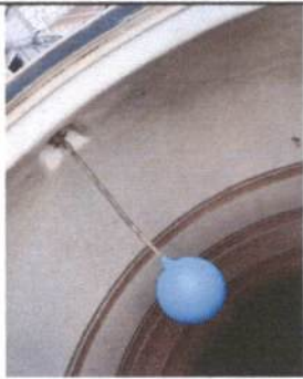
Foto 6: Sustitución de accesorios para depósito de agua.
