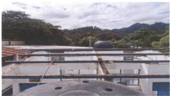
Foto 10: Mantenimiento a estructura de soporte de metal
