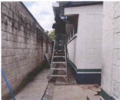
Foto 3: Instalación y bajadas de agua pluvial
