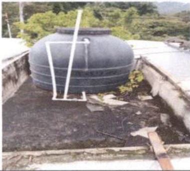
Foto 5: Reparación y mantenimiento de sisterna
