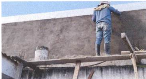
Foto 7: Repello en muro
