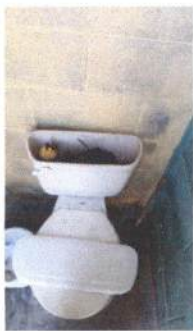
Foto 9: Sustitución de accesorios inodoro (contra llave, tubo de abasto y tanque)
