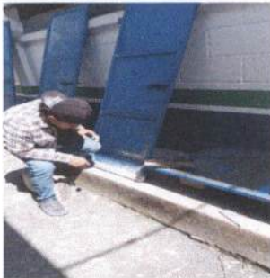
Foto 11: Mantenimiento a estructuras
