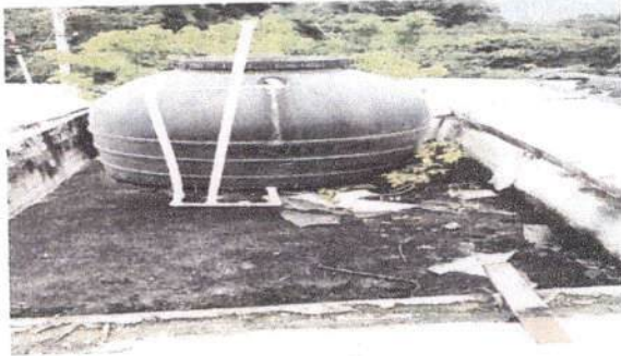
Foto 6: Sustrución de accesorios deposito de agua
