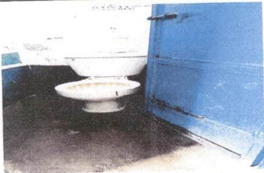
Foto 5: Mantenimiento a estructura (lijado, cambio de tubo , cepillado, sujeciones, aplicación de pintura) a puertas servicios sanitarios
