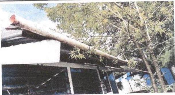
Foto 4: Instalación de canal de metal
